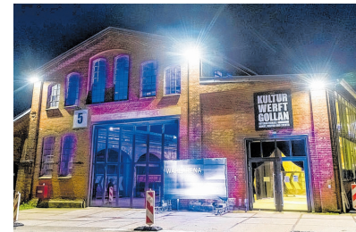
Seit 2015 werden die alten Industriehallen für Veranstaltungen genutzt.
