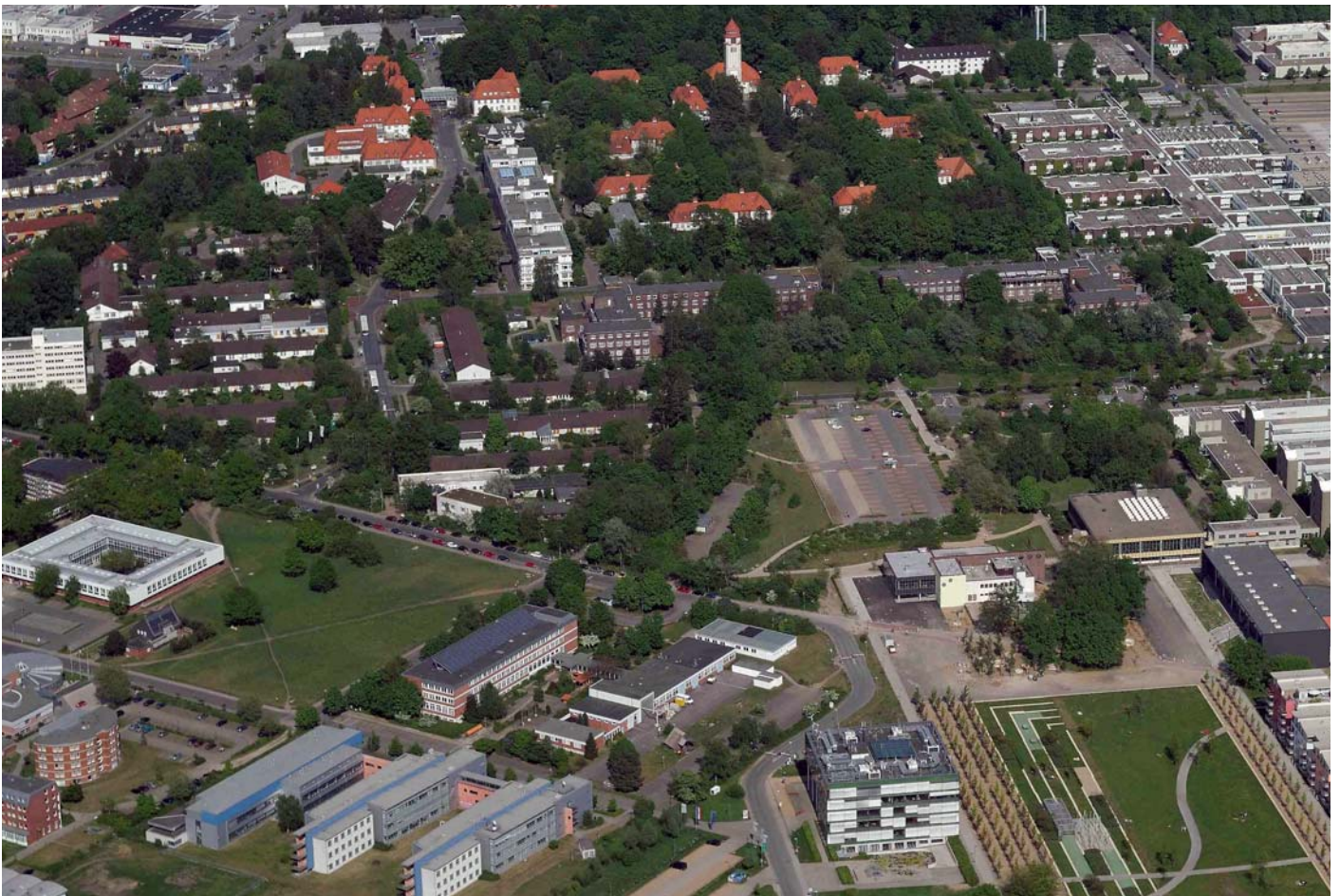
Luftbild des Wissenschaftscampus Lübeck mit Blickrichtung von Westen: linker Bildrand Mitte: Bushaltestelle Mönkhofer Weg, links unten: Fachhochschule, unten Mitte: MFC, Mensa, Bibliothek und Audimax, Bildmitte: Kliniken und Institute der Universität, rechts: Zentralklinikum, oberer Bildrand: Ratzeburger Allee (Foto: Uni Lübeck)
